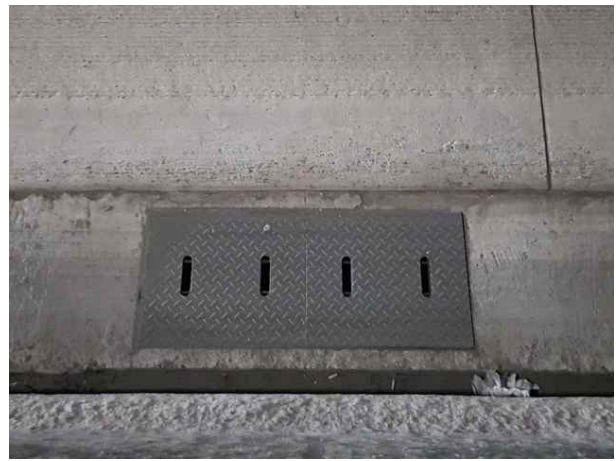
본선 배수시설 상태양호
