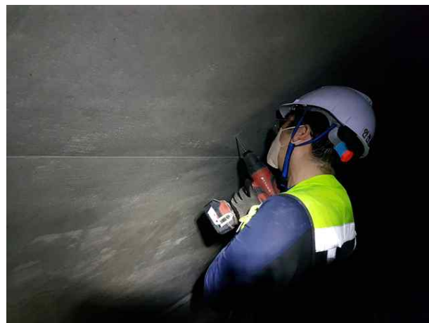
탄산화 깊이 측정(드릴링)
