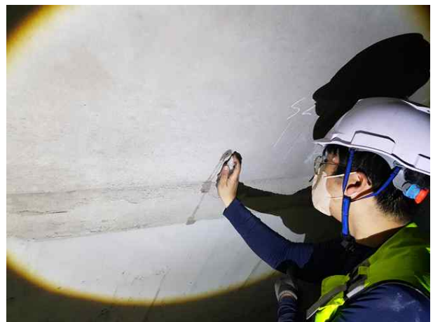
탄산화 깊이 측정(페놀프탈레인)
