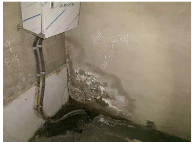
RAMP-C NATM구간 측벽부 S68 균열( C_w=0.3\text{mm} ) 및 누수(스며있음)
