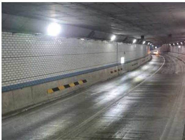
본선 BOX구간 벽체 전경
