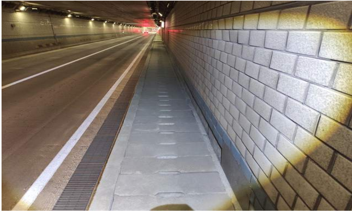
NATM구간 공동구 전경
