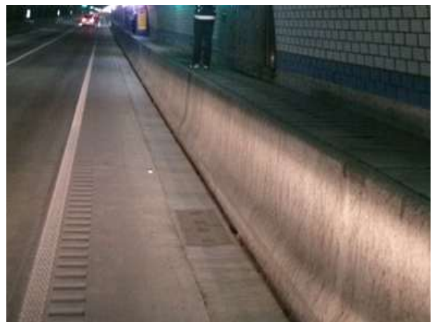
본선 배수시설 상태양호
