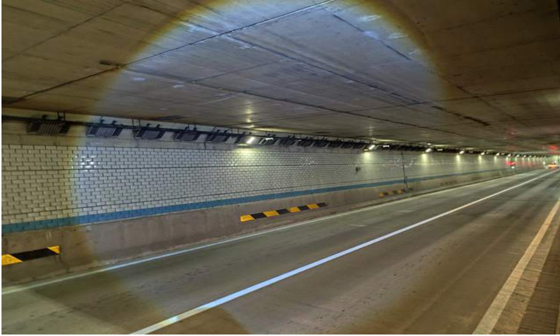
BOX구간 벽체 전경
