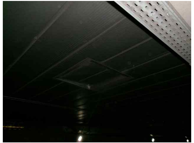
본선 NATM구간 풍도슬래브 S505 점검문 파손
