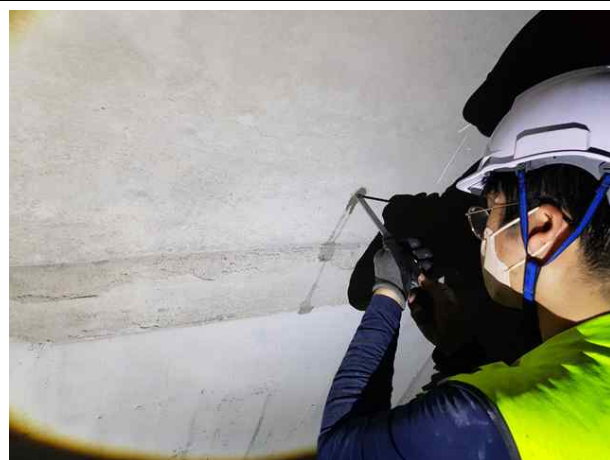
탄산화 깊이 측정
