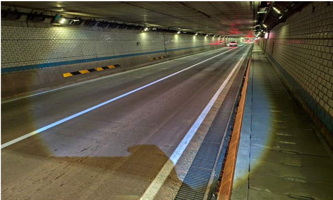
BOX구간 포장 전경
