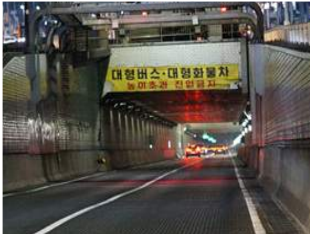
갯문 진입부 상태양호
