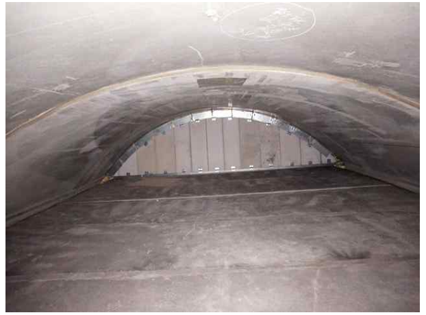
풍도슬래브 내부 전경(격벽)
