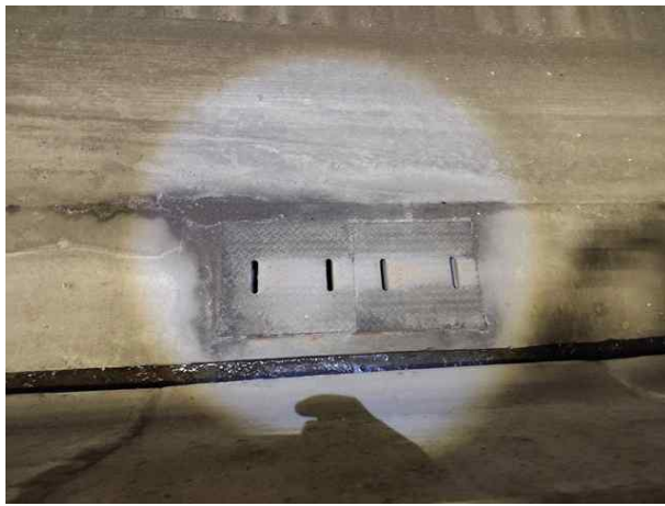
본선 배수시설 상태양호
