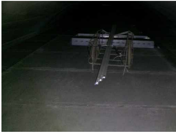
RAMP-C 풍도슬래브 S53 내부 자재적치
