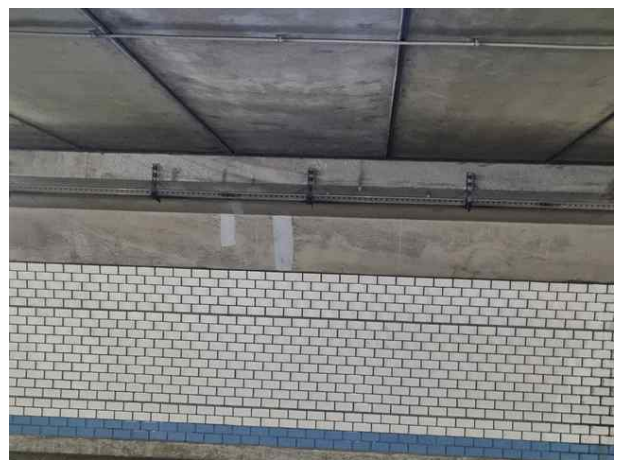
본선 NATM구간 측벽부 누수,백태 보수 양호
