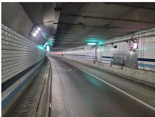
RAMP-C BOX구간 벽체 전경
