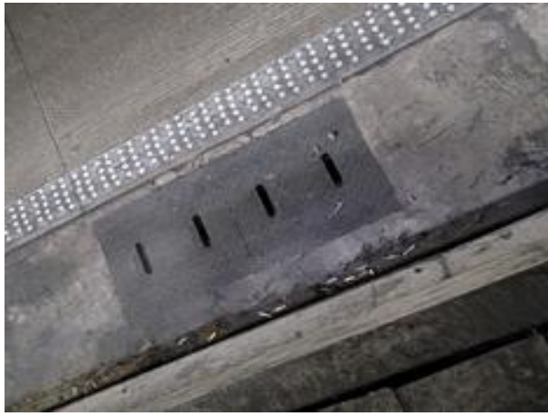
RAMP-C 배수시설 상태양호
