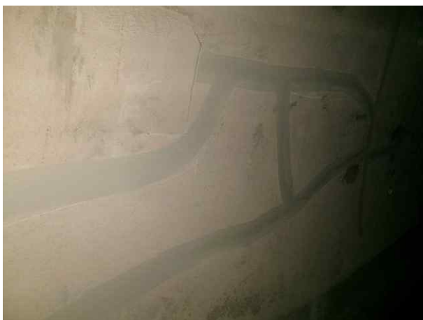
RAMP-C NATM구간 측벽부 균열보수 양호
